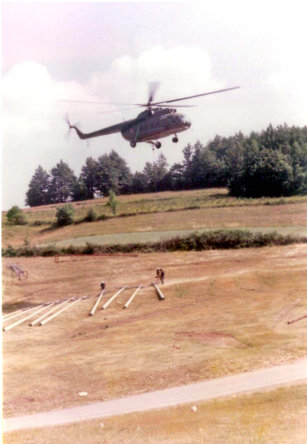
Prilikom izgradnje jednog od zadnjih dalekivoda 10 kV (Ovčarska farma „Crni vrh“) korišćena je pomoć helikoptera JNA (snimak načinjen 20.07.1984)
