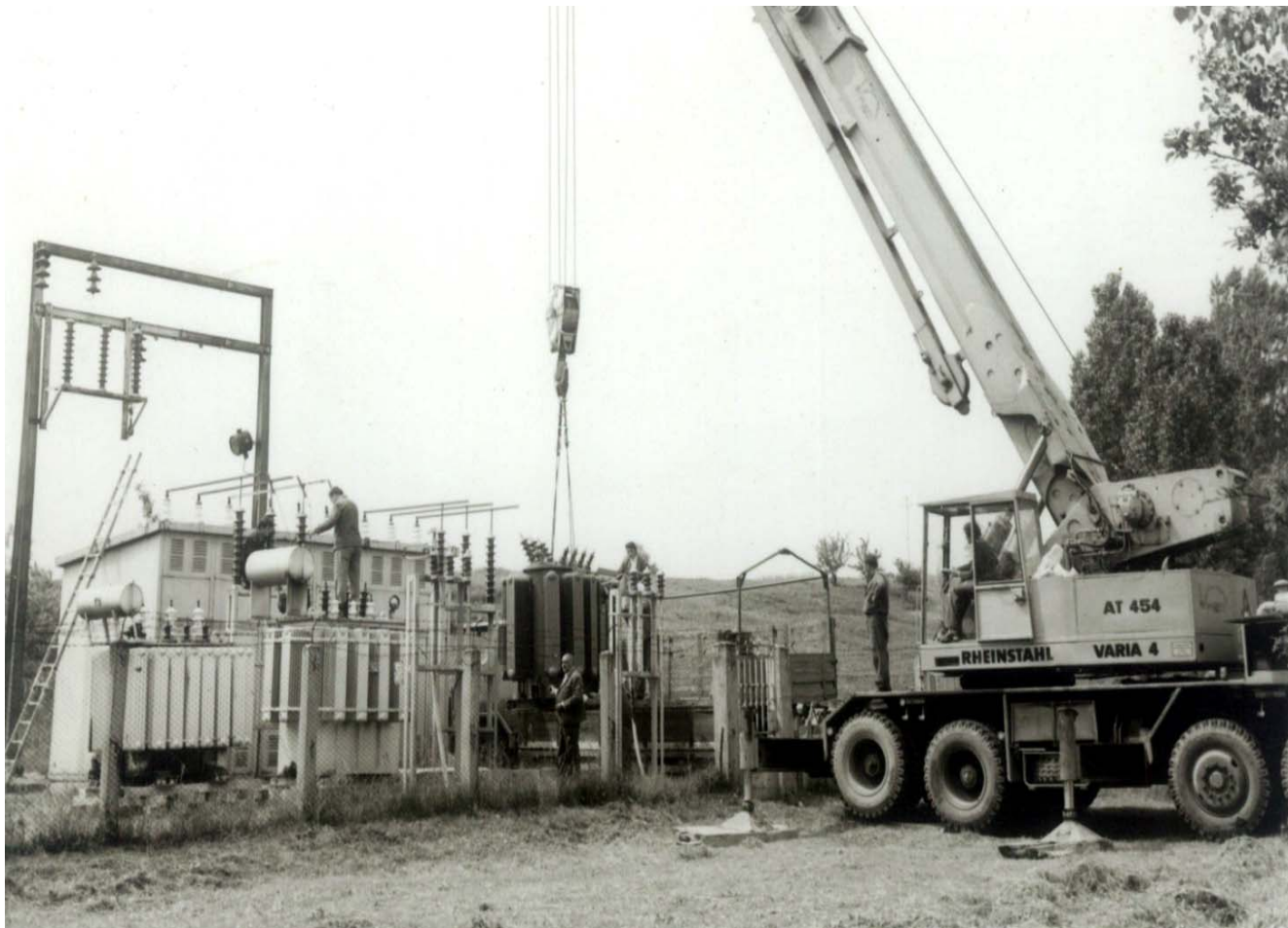
1960. Izgradnja trafo stanice 35/10 kV u Babušnici
