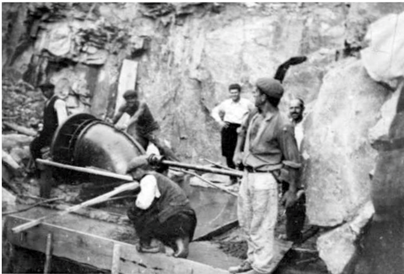
1940. Ugradnja Francisove turbine
