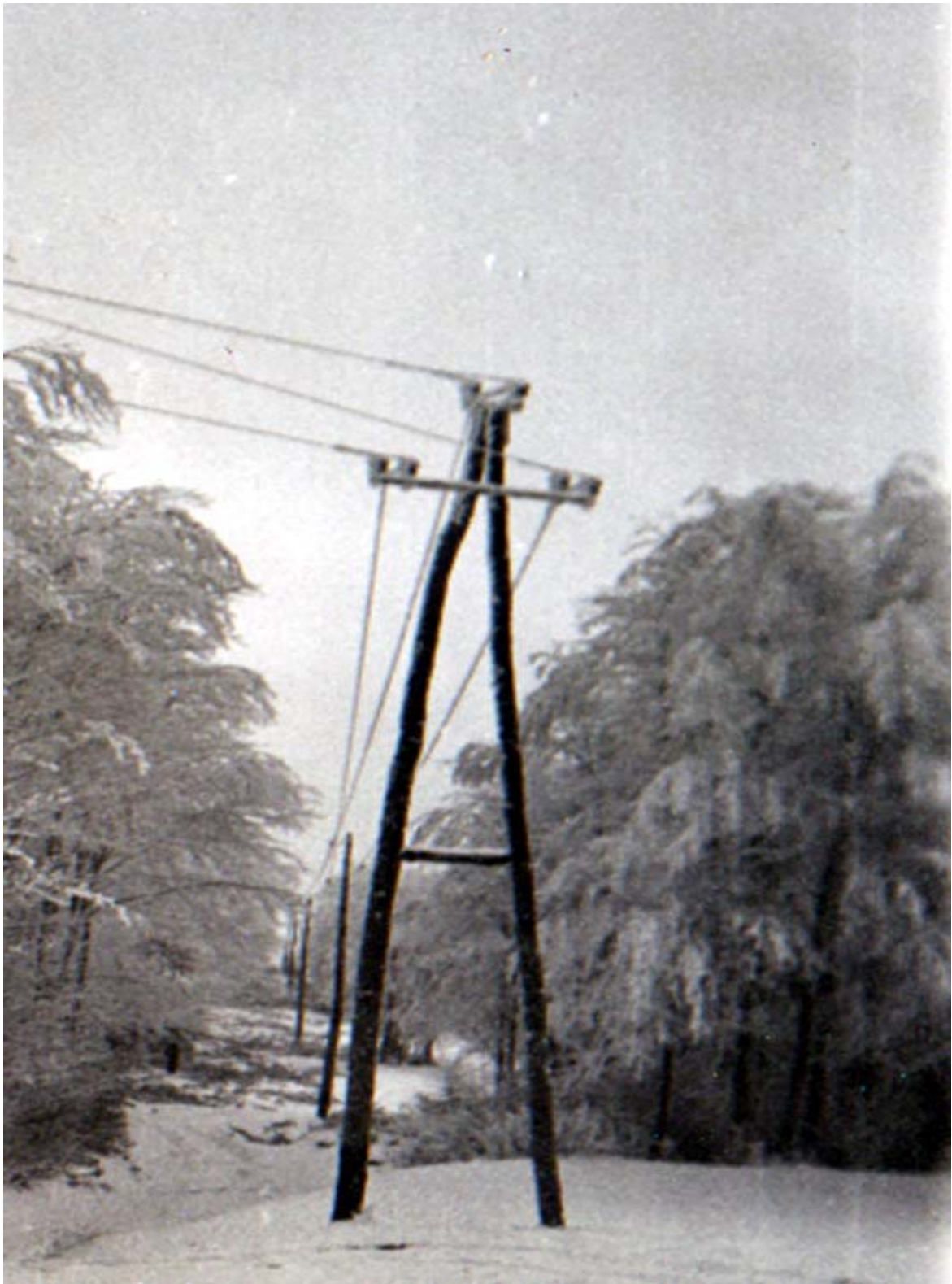
1951. Gradi se dalekovod 10 kV Ljuberađa – Babušnicana na drvenim stubovima
