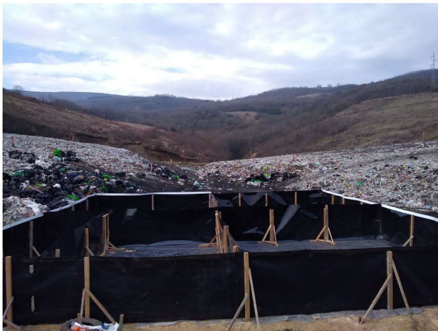
Слика бр.7.1: Одвојени простор за депоновање отпада који у себи садржи чврсто везани азбест, гипс и стаклену вуну
